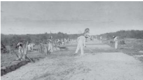
Construção da BR-222 no trecho entre os municípios de Croatá e São Luís do Curu, em 1932. Vingren transitou pela rodovia, na época, vereda, em dezembro de 1914 e janeiro de 1915.
